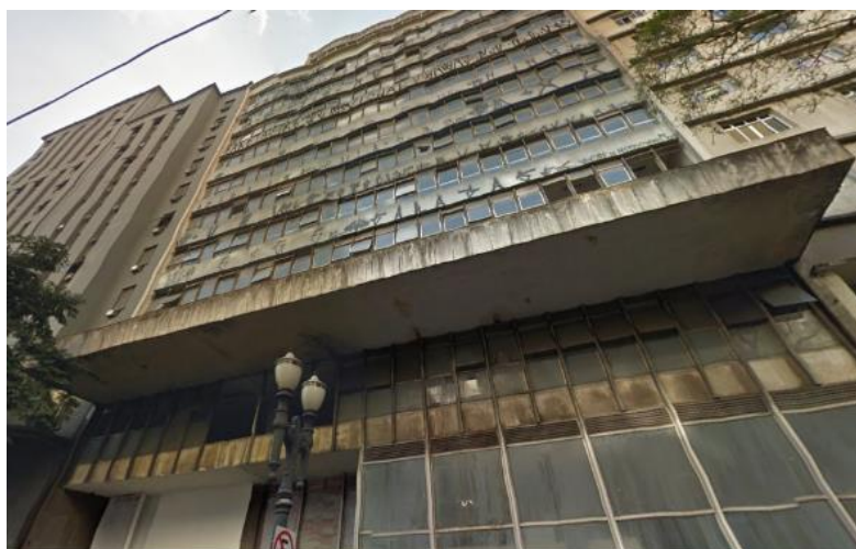
Figura 1: Edifício Ipiranga – Ocupação aprovada pelo MCMV. Fonte: http://www.pac.gov.br/noticia/be70e7e0 Acesso: 17.08.16 às 15:00
