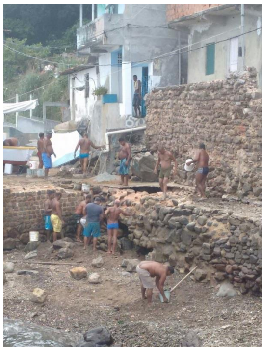
FIGURA 05: Mutirão para reconstrução de parte da passarela de acesso ao Forte de São Paulo. FONTE: Adriano de Jesus. Dezembro de 2015
