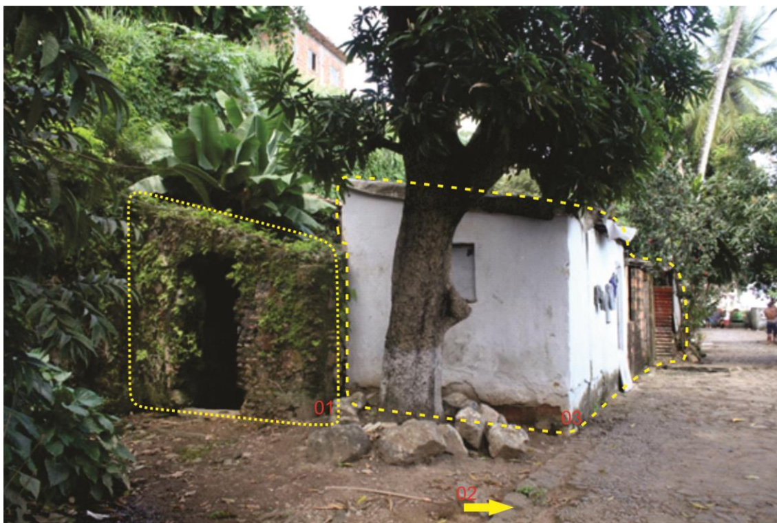
Figura 05: Casas(03) sobre a estrutura original do Forte(01). Fonte:Fabrício Zanoli. Dezembro de 2015
